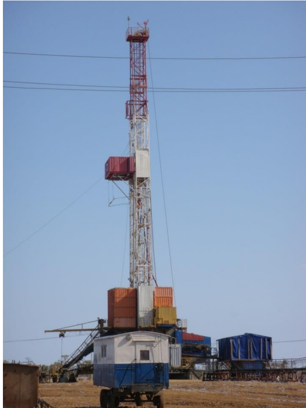
Рис. 1. Установка для бурения скважин
