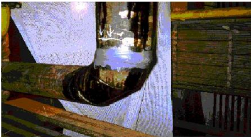
Рис. 4. Заделка течи трубопровода
